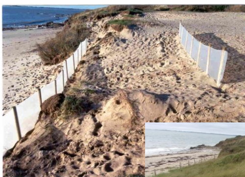
DOPO +10 anni dall'installazione di Mobi-fence
